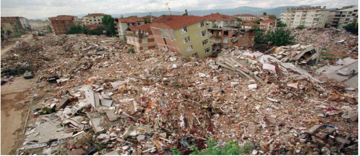
Gölcük Depreminde Hasar gören binalar.
